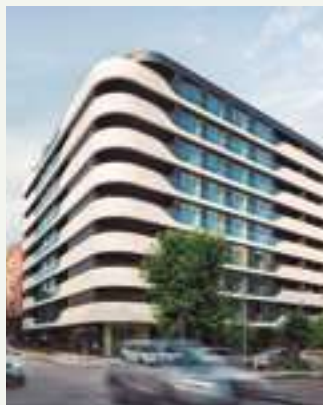
Výjimečná obytná budova v Bulharsku s účinným řešením HVAC. Aquarea
