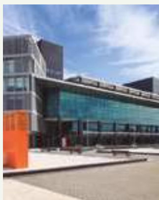
Technologický park v Andalusii. Kanceláře s vysokou energetickou efektivitou. Španělsko. ECOi
